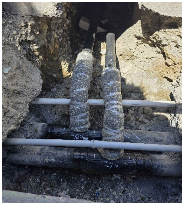
Abgang der Fernwärmeleitung für einen Hausanschluss mit Vor- und Rücklauf.
