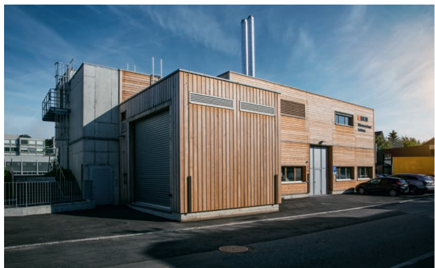
Zentrale Wärmeverbund Köniz Schliern
